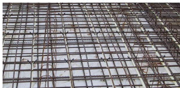
Beispiel: Rohrbefestigung auf der oberen Bewehrung
